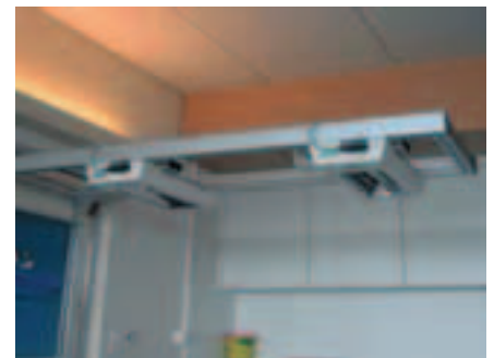
Hållare för värmelampa i taket
