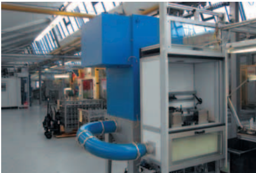
Ljudisolering för fläkt
