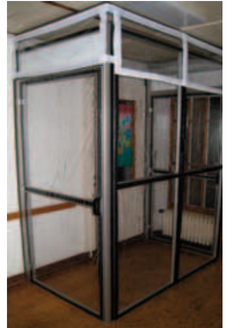
Låsbart rum för dammskydd
